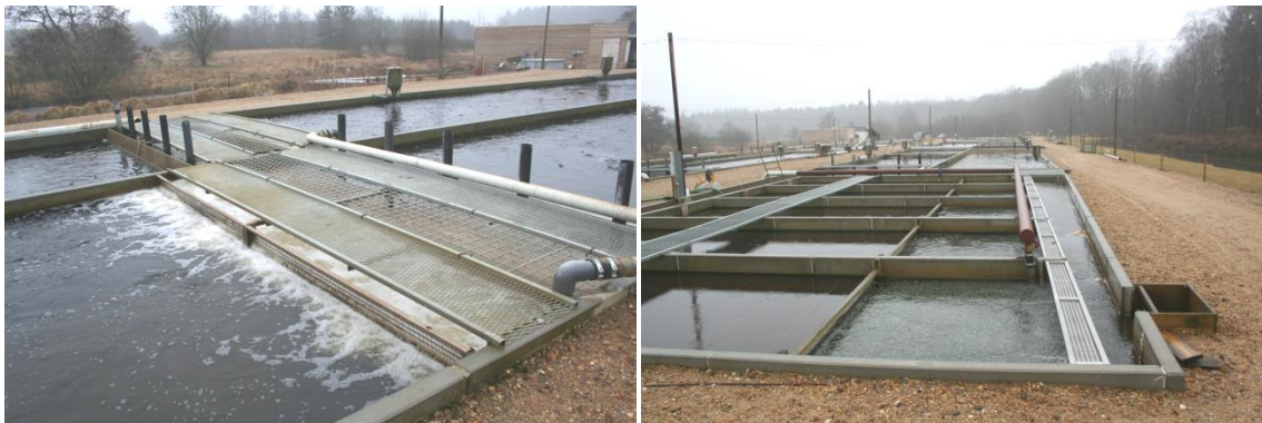
Airlift a biologický filtr uvedeného systému (Dánsko, Hallundbaek).
