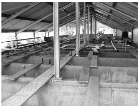
Obrázek 4: Přístavba zastřešení u RAS v Mlýnech u Vimperka
