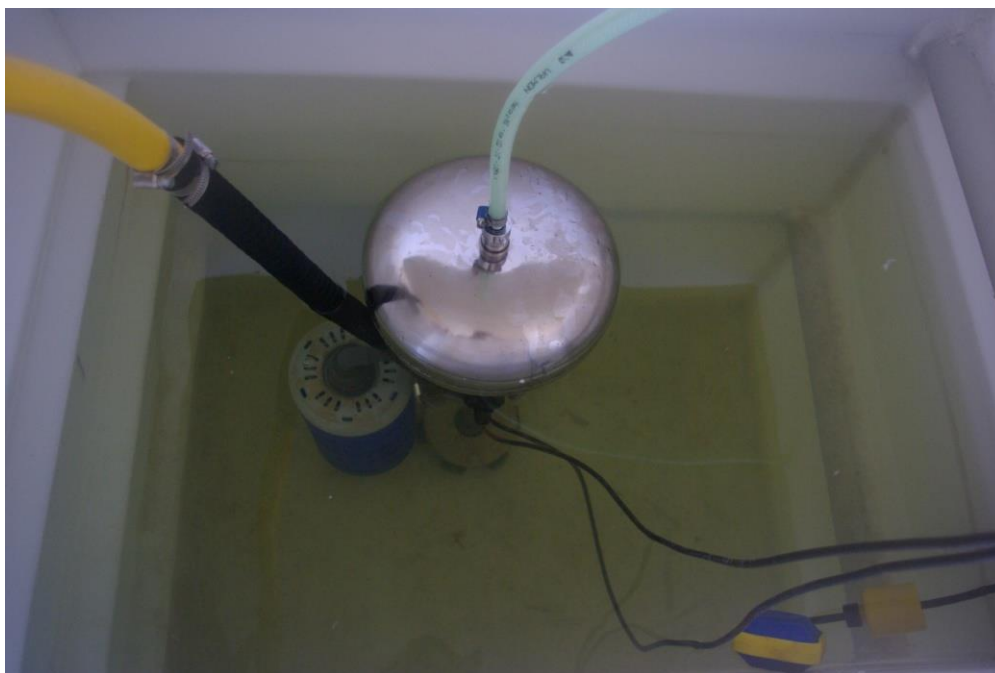
Obrázek 4: Systém AQUALOOP - umístění v nádrži
