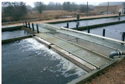
Obr. 6. Airlift a biologický filtr uvedeného systému (Hallundbaek, Dánsko) (foto: J. Mareš).
