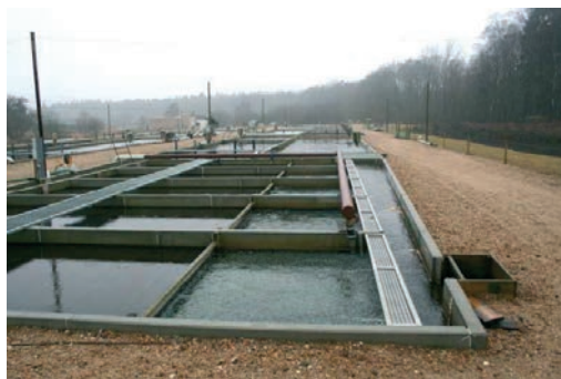
Obr. 6. Airlift a biologický filtr uvedeného systému (Hallundbaek, Dánsko) (foto: J. Mareš).
