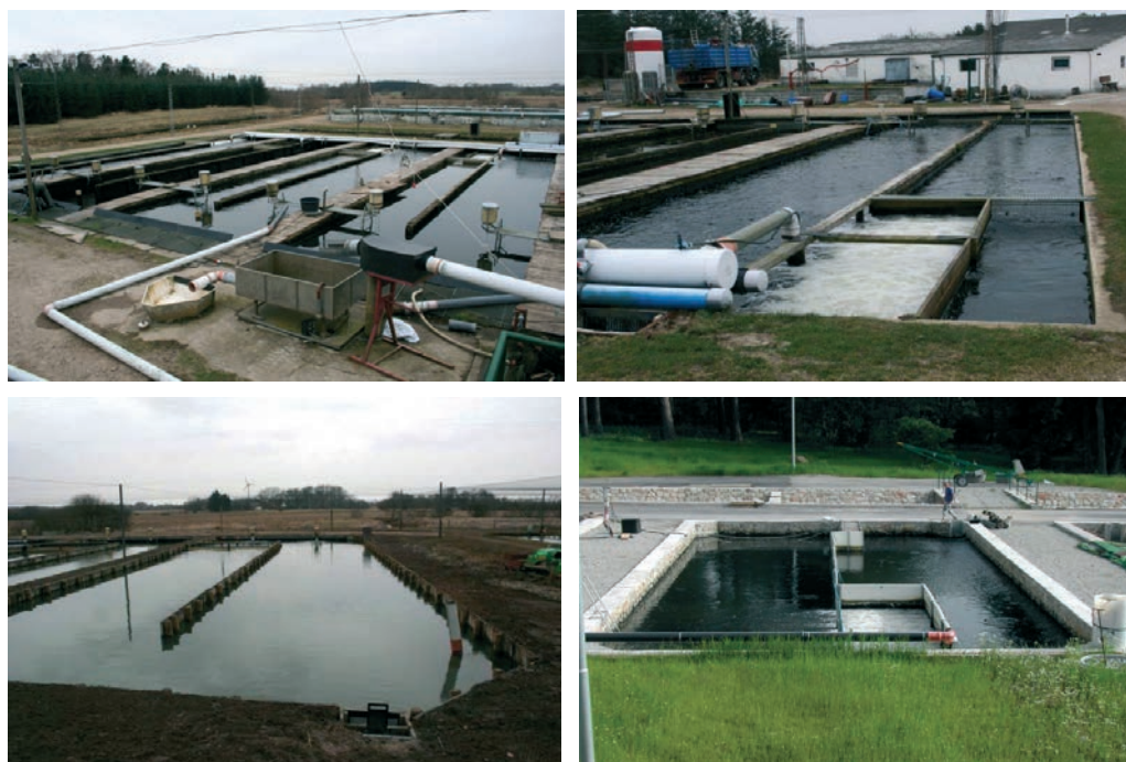
Obr. 10. Nádrže s dělicí stěnou a sedimentačními kužely (Dánsko 1–3, Pravíkov vpravo dole) (foto: J. Mareš).
