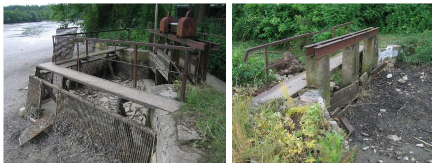
Obr. 3. Mlékovický rybník – bezpečnostní přelivy po povodni (5. 6. 2013)
