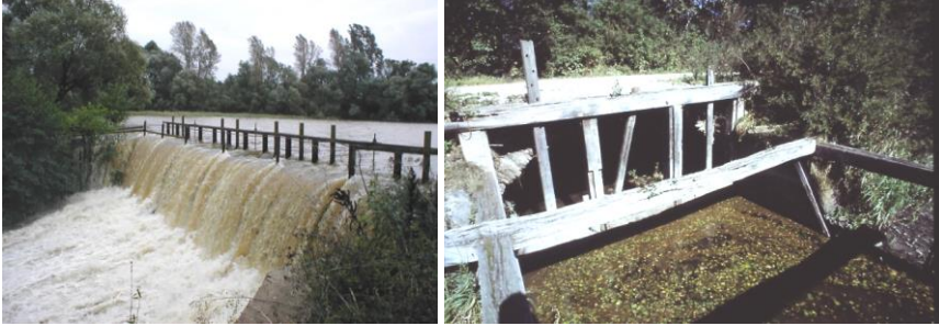
Obr. 8. Nevyhrazený hrazený přeliv při povodni (vlevo); původní dřevěná konstrukce hrazení (vpravo).
