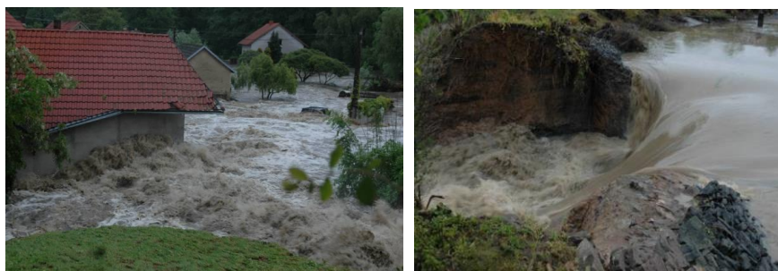
Obr. 2. Mlékovický rybník při protržení hráze.
