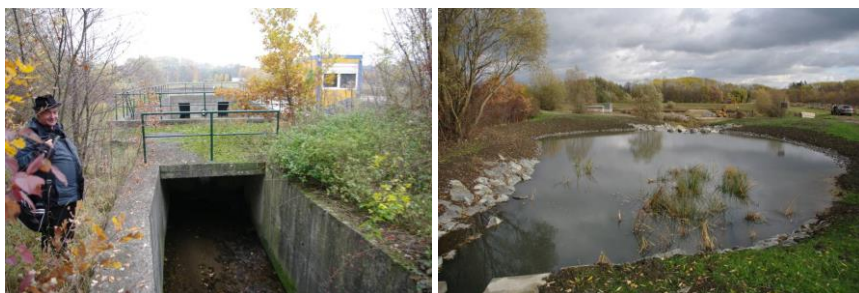
Obr. 2. Nátok do retenční nádrže Říčanka před revitalizací (vlevo) a po revitalizaci (vpravo).
