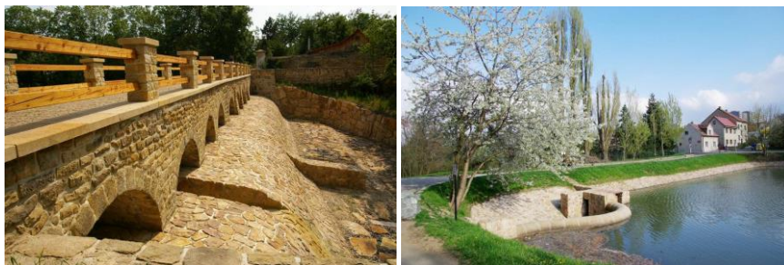
Obr. 1. Bezpečnostní přeliv a most Počernického rybníka (vlevo); bezpečnostní přeliv RN Hájecká (vpravo).
