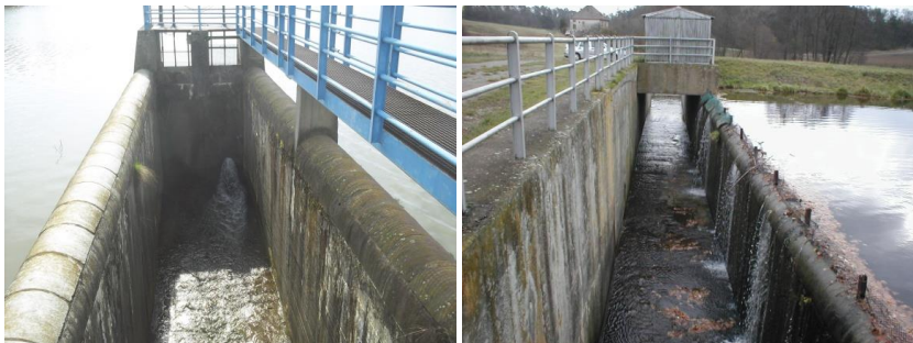
Obr. 10. Boční přeliv se skluzem (vlevo); sdružený objekt (vpravo).
