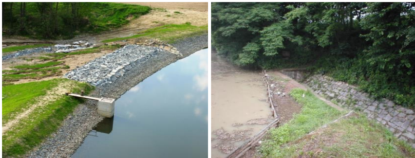
Obr. 9. Přímý přeliv bez žebra po povodni (vlevo); boční přeliv, nekapacitní (vpravo).
