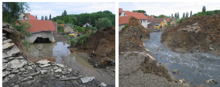
Obr. 4. Mlékovický rybník 5. 6. 2013 – pohled průřvou do podhráží a dočasný překop hráze.
