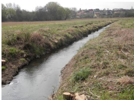
Obr. 1. Celkový pohled na místo před realizací – napřímený Zákolanský potok protékající lokalitou s vymýceným porostem.
