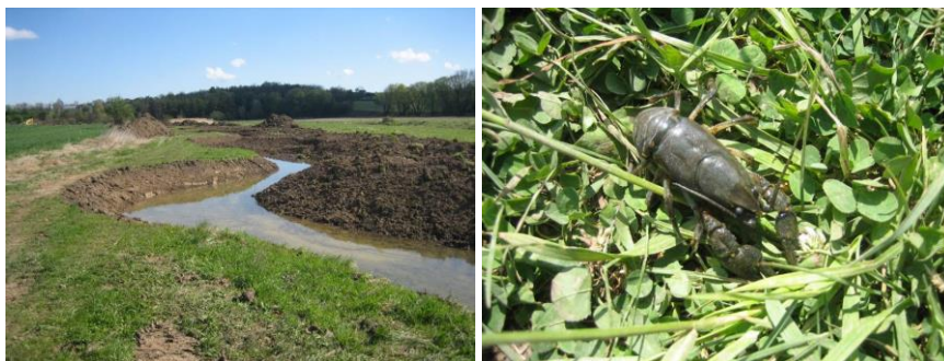
Obr. 3. Obtokové koryto – zemní práce (vlevo); rak kamenáč (vpravo).
