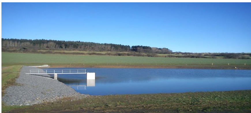
Obr. 4. Nádrž těsně po dokončení – napouštění
