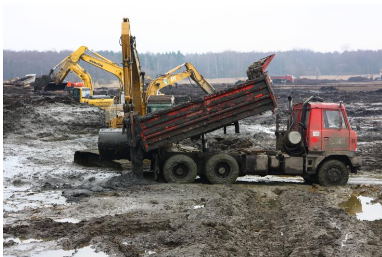
Obr. 1 Transport řídkého sedimentu ze dna na mezideponii.
