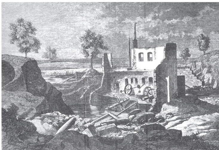
Obr. 4. Situace pod protrženými rybníky ve Stebně, z parní pily zbyla jen odolnější část postovaná souběžně s proudem (Hugo Ullik)
