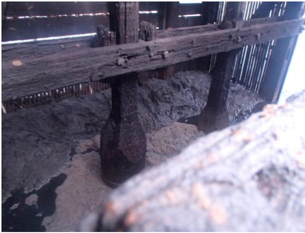
Obr. 3 Dřevěné čapy na potrubí spodní výpusti.
