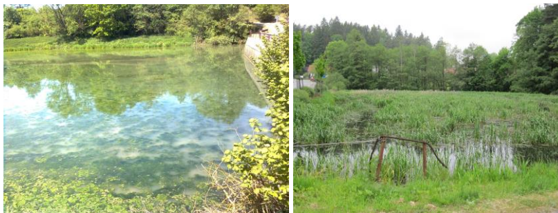
Obr. 1 Zazemňování nádrže - Mlýnský rybník Roblín (vlevo), zarůstání nádrže – rybník v obci Skála (vpravo)
