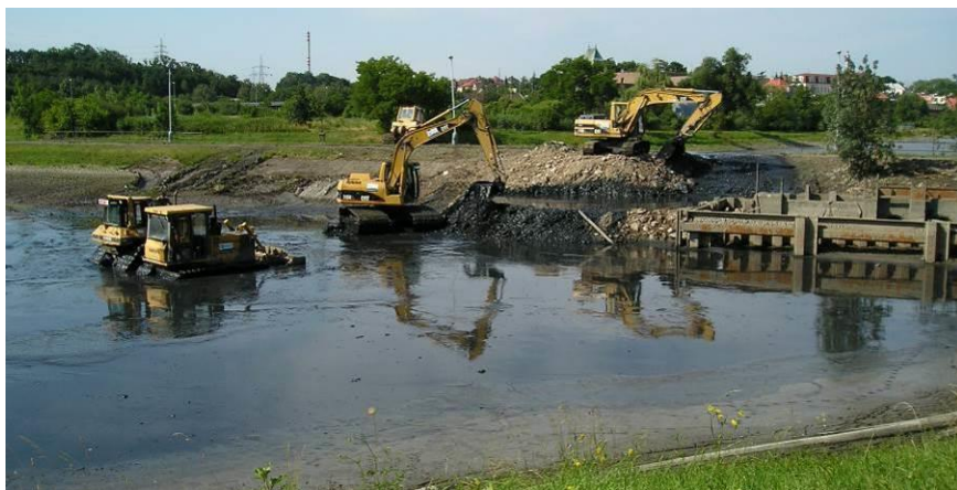
Obr. 4 Nakládání zvodněného sedimentu
