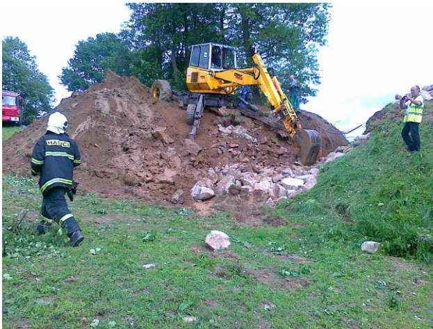
Obr. 4 Řízené prokopávání hráze.
