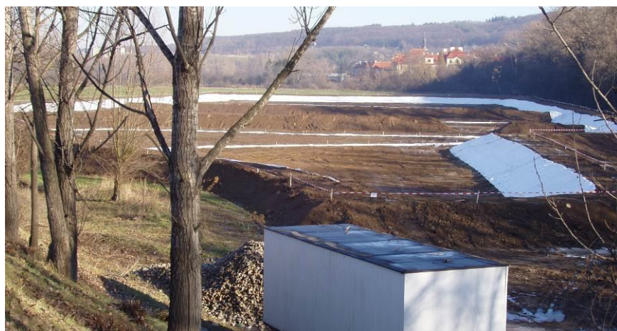
Obr. 2 Výstavba kalového pole vedle Krňáku
