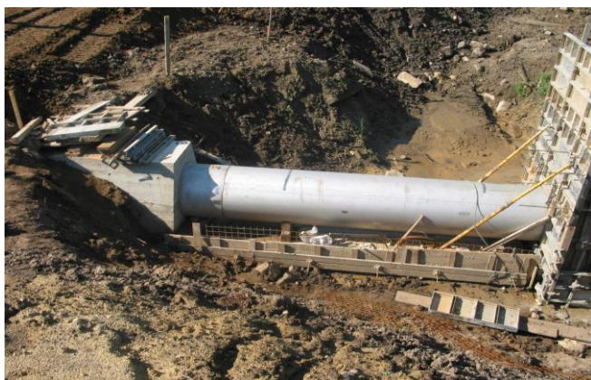
Obr. 1 Výstavba sruženého objektu s výpustí v tělese hráze
