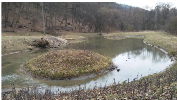
Obr. 1 Sedimentační nádrž na řece Kuřimce (pohled ve směru toku)
