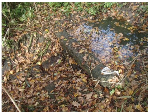
Obr. 4 Trubní jáma na výtoku
