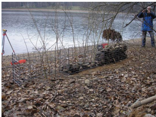
Obr. 7 Gabion při realizaci
