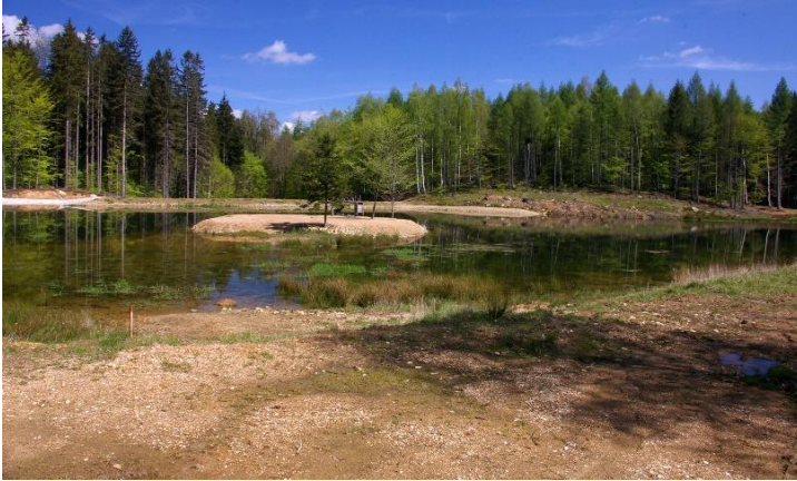
Obr. 1 Realizace nové retenční nádrže (Pustý potok, Raspenava) na lesních pozemcích v CHKO Jizerské hory postižených větrnou kalamitou. Jako doprovodné opatření byly realizovány neprůtočné tůňe a ostrov. Nově vzniklé biotopy vytvořily podmínky pro rozvoj obojživelníků, zvýšení druhové pestrosti vodních rostlin včetně ornitologického přínosu.
