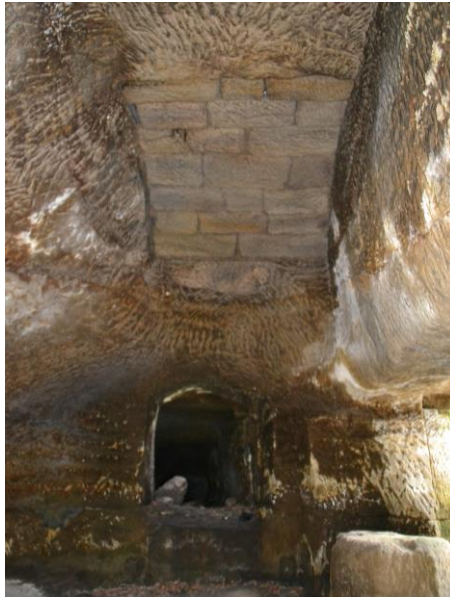
Obr. 5 Dolanský rybník, relikty zaniklého mlýna v těsném sousedství hlavní výpusti, pohled do skalní lednice, kde se nacházelo vodní kolo, v pozadí náhon z rybníka sekaný ve skále, foto I. Peřina 2016.
