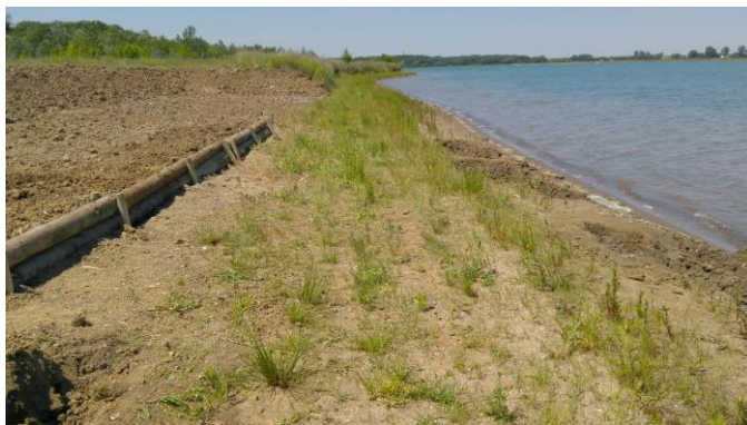
Obr. 3 Realizované stabilizace v břehové části nádrže Hulín
