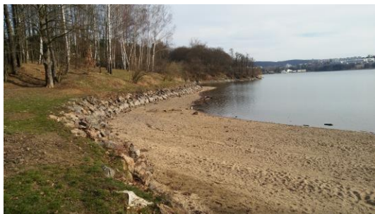
Obr. 4 Pasivní ochrana břehu na VD Brno – kamenná rovnanina
