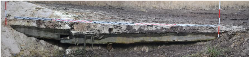
Obr. 6 Mlýnský rybník, východní okraj vypuštěného rybníka, detail odhalené trámové konstrukce loviště, foto I. Peřina 2012.
