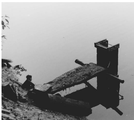
Obr. 3 Ponořený požerák
