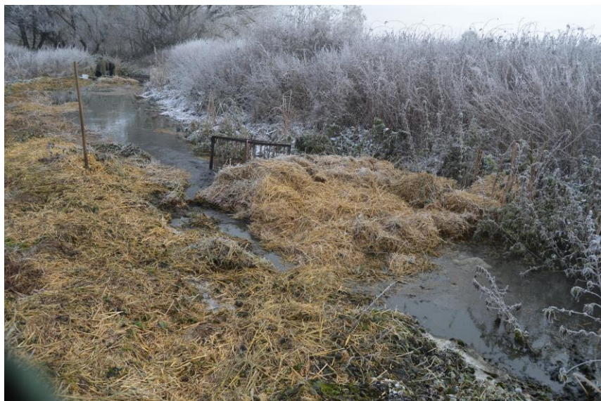
Obr. 2 Instalace dočasných hrázek z balíků slámy pod rybníkem Novokoželský v průběhu výlovu (foto, J. Regenda).
