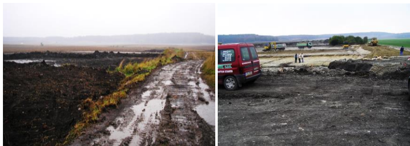
Obr. 5 Stav před výstavbou vodní nádrže (vlevo) a výstavba vodní nádrže (vpravo)
