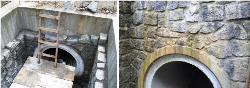
Obr. 8 Příklad porušení technologické kázně – pracovní spára (nad obkladem v čele objektu) neměla v těchto místech vůbec vzniknout a pokud už vznikla, měla být řádně ošetřena - což se nestalo (vlevo, foto autor); výsledek nekvalitně ošetřené pracovní spáry – patrné průsaky již po několika týdnech od napuštění nádrže (vpravo, foto autor)
