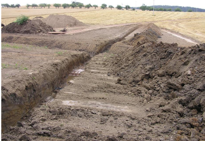
Obr. 5 Výkop pro zavazovací ostruhu hráze a těsnící jádro hráze
