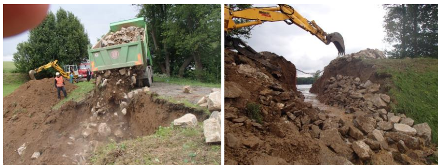
Obr. 4 Budování nouzového přelivu při průchodu povodně
