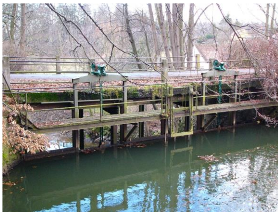
Obr. 3 Převodové zdvihací mechanismy
