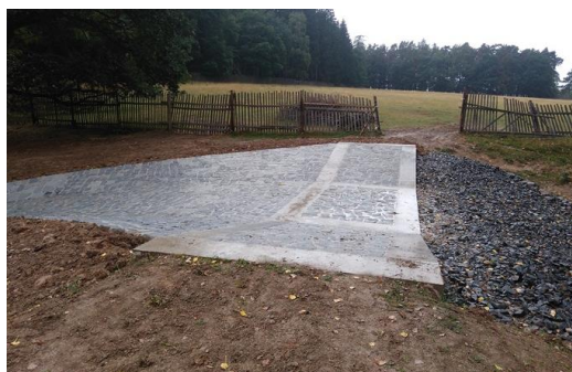
Obr. 4 Přímý, lichoběžníkový přeliv – dlažba z lomového kamene do betonového lože stabilizovaná betonovými žebry (foto Ing. T. Rau)
