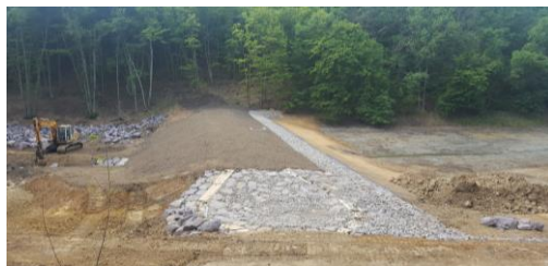
Obr. 5 Přímý, lichoběžníkový přeliv – rovnanina z lomového kamene stabilizovaná betonovými žebry (foto Ing. T. Hofmeister)
