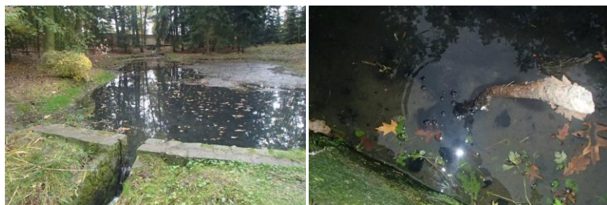
Obr. 6 Retenční nádrž pod ČOV Jesenice v parku (říjen 2016) – celkový pohled (vlevo), anaerobie s bublinkami metanu (vpravo). Foto E. Maršálková
