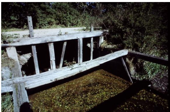
Obr. 1 Původní dřevěná konstrukce s tabulemi
