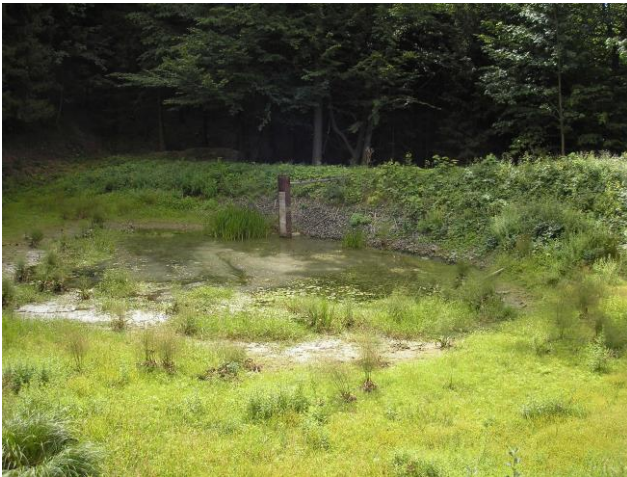
Obr. 2 Pohled na návodní stranu hráze s ocelovou výpustí nádrže Bába (Marková 2017)
