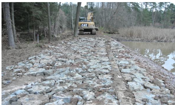
Obr. 7 Přímý, lichoběžníkový přeliv – rovnanina z lomového kamene, přelivná hrana zajištěna betonovým pasem (foto Ing. L. Jůn)
