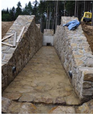
Obr. 2 Sdružený objekt – betonová, monolitická konstrukce s obkladem – pohled proti toku (foto autor)
