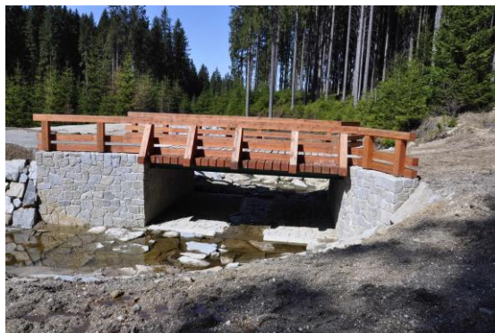
Obr. 1 Betonová monolitická konstrukce s obkladem – pohled po toku (foto autor)
