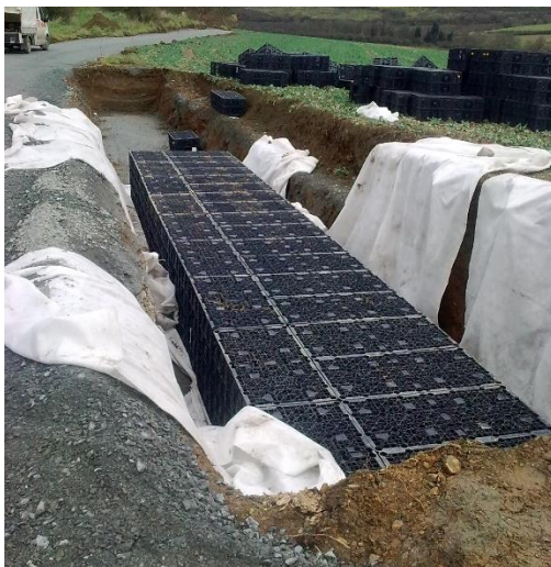
Obr. 4 Vsařovací jáma s galeriemi a fólií před zasypáním
