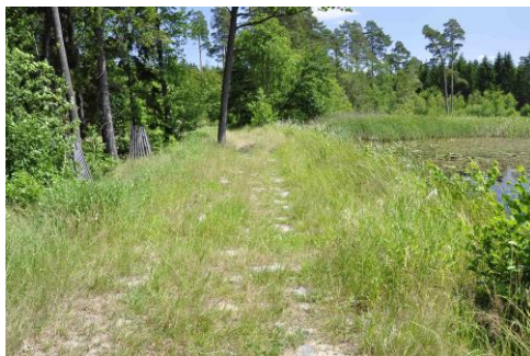
Obr. 10 Příklad vhodného způsobu souladu opevnění bezpečnostního přelivu a okolního prostředí. Opevnění není 4 roky po výstavbě téměř patrné. Způsob provedení viz obr. 7 (foto autor)
